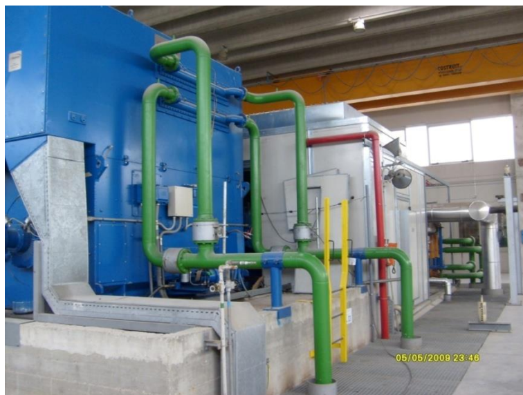
Fig. n. 1.3.8: Sala turboalternatore ( edificio D )
