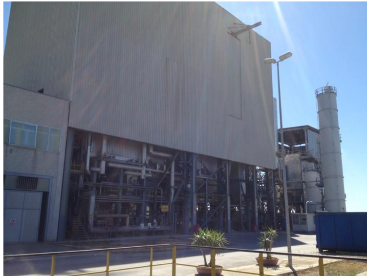
Fig. n. 1.3.7 : Caldaia ( edificio F )
