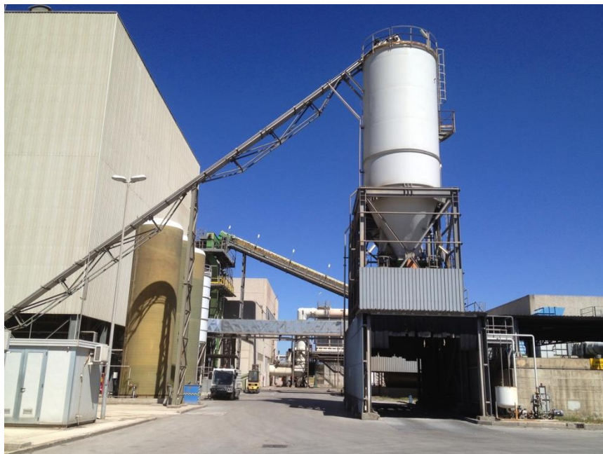
Fig. n. 1.3.11: Silo di raccolta ceneri leggere
