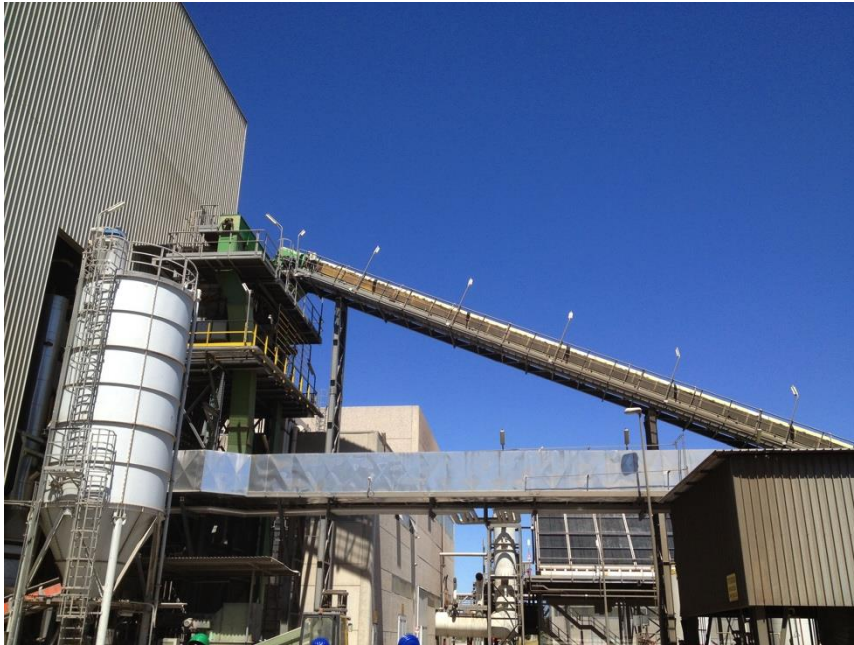
Fig. n. 1.3.5: Sistema di distribuzione combustibile
